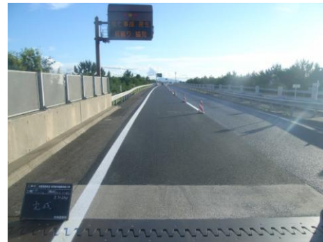
損傷部の補修 日本海東北道 新潟亀田IC～新潟空港IC
