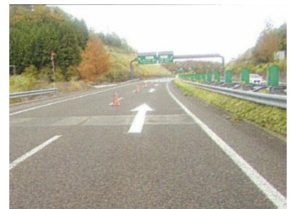
IC 合流部における路面標示の施工
