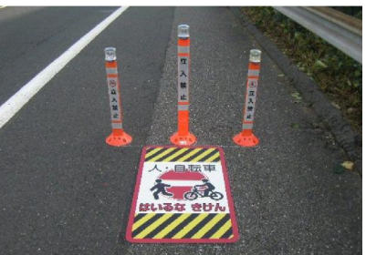
IC 入口路肩部に設置した進入禁止ポール
